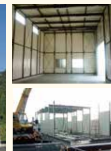
外壁・断熱材・内壁を一度に施工し、工期を短縮。
