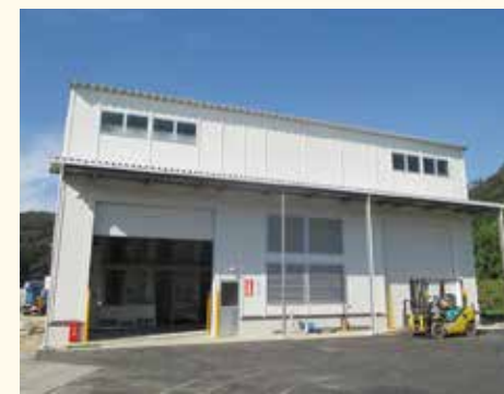
外壁・断熱材・内壁を一度に施工し、工期を短縮。
