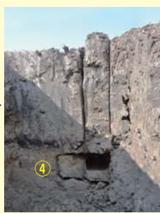
3 サイドカッター④で空洞横の土を切断
