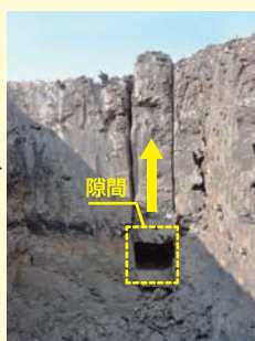
2 切断した土を押上刃③で持ち上げ、下部に隙間をつくる
