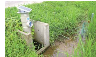
◀精密な水管理を可能にしたほ場水管理システムWATARASの電動アクチュエータ(写真は給水側)
